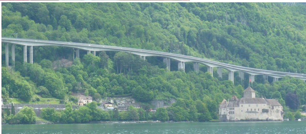
図7 UHPFRCを床版の補修・補強に適用した有名なシオン高架橋の現状外観
