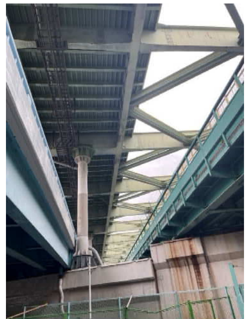
写真-3 木津川大橋桁下
