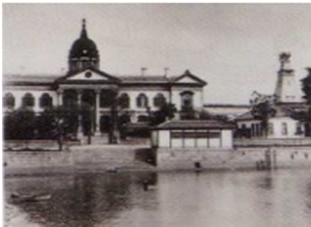
写真-4 初代大阪府庁舎の威容
