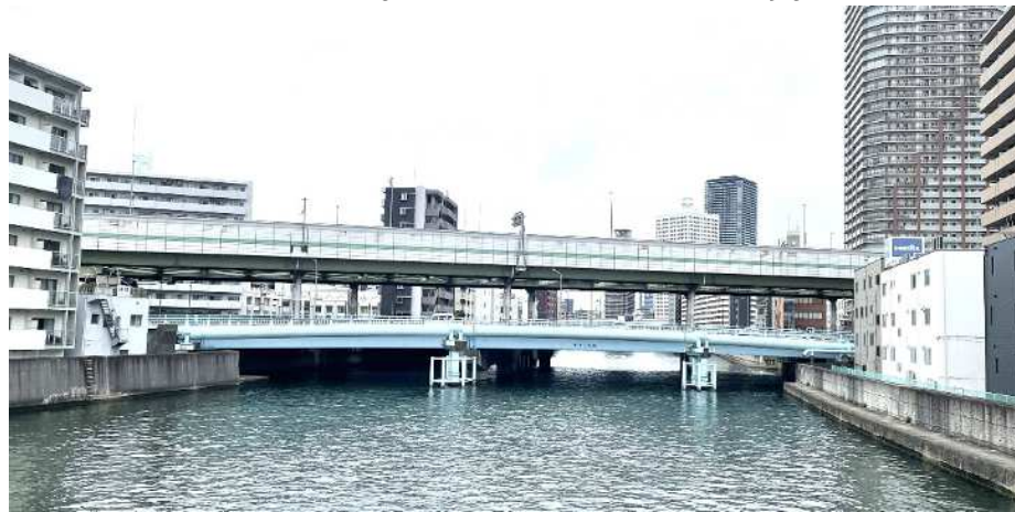
写真-1 木津川大橋全景
