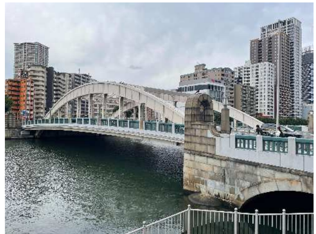
写真-2 長寿命化と修景後の橋梁
