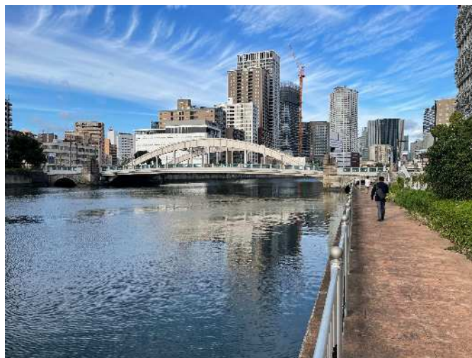
写真-1 堂島大橋全景
