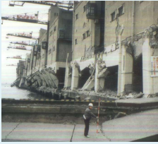
コンテナターミナルの液状化
