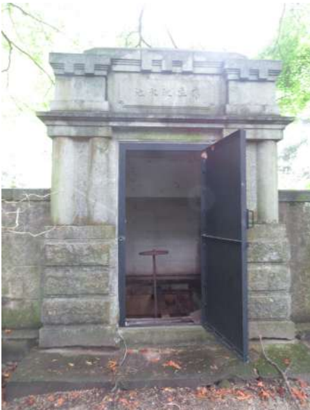
高地区配水池正面 上部には意匠
