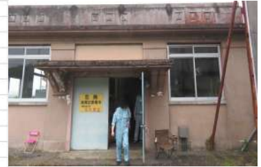
写真-1 ①木津浄水場ポンプ室
