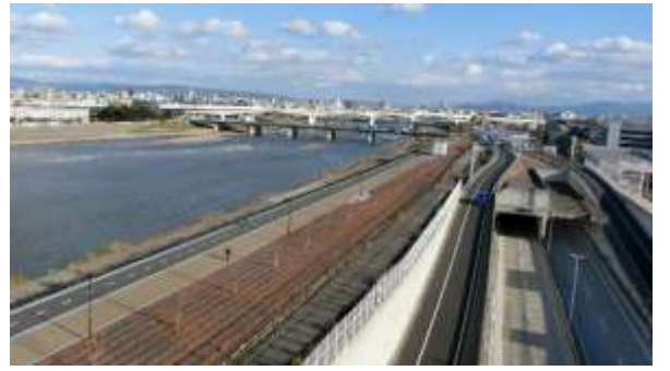
上流側（大和川大橋方面を望む）
