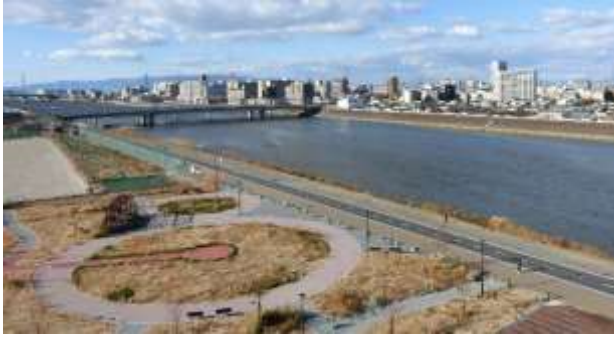
下流側（堺大橋方面を望む）
