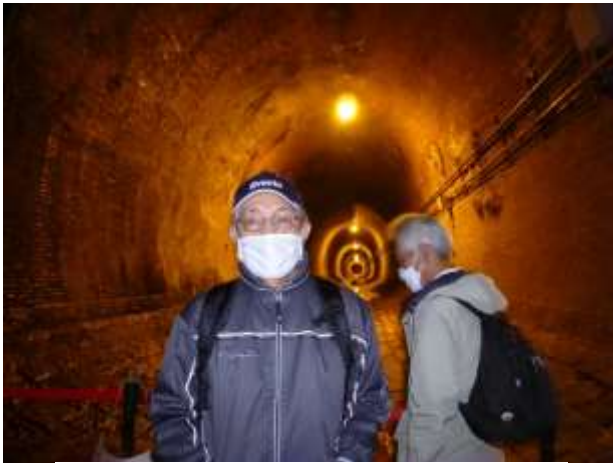
湊川隧道内部
