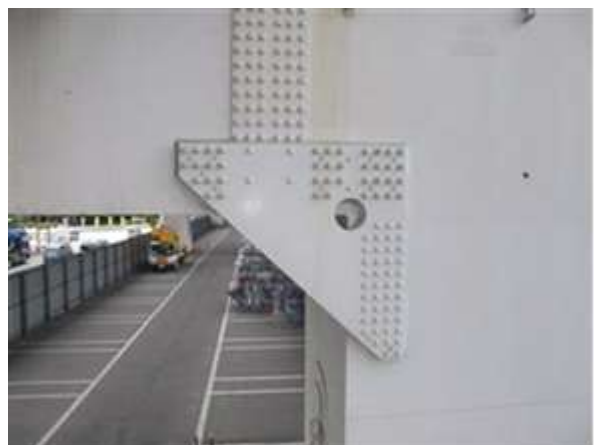
写真-4 鋼製橋脚隅角部の補強 (2003 年)
