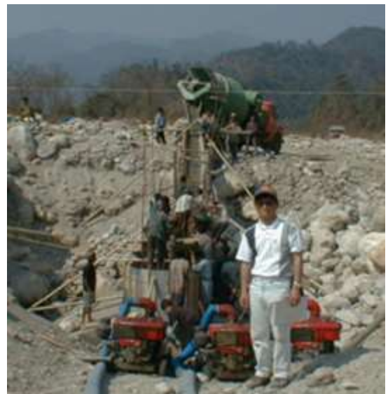
写真-2 ブルコラ橋の施工(1999年2月)
