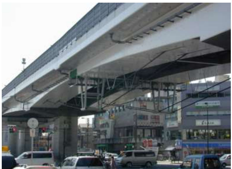
写真-5 下弦ケーブルによる喜連瓜破橋の補強 (2003 年 10 月)
