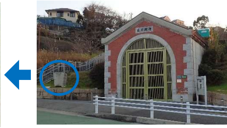
写真-6 湊川隧道の入り口
