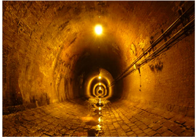
写真-1 湊川隧道（内部）
