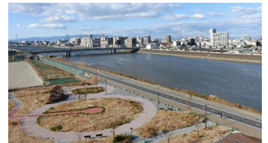
写真-4 下流側・阪堺大橋方面
