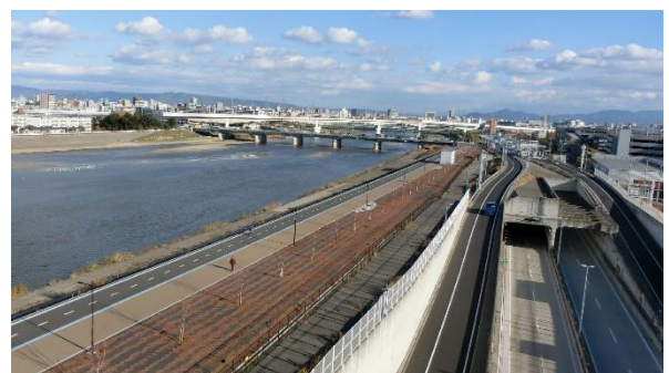
写真3 上流側（大和川大橋方面を望む）
