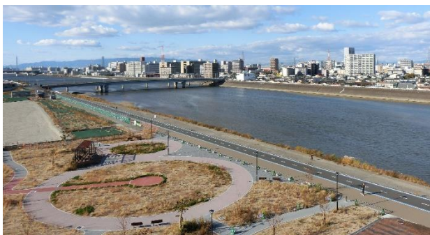
写真2 下流側（阪堺大橋方面を望む）
