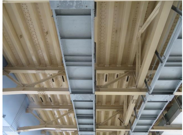
写真 9 トラス組の縦桁、横桁
