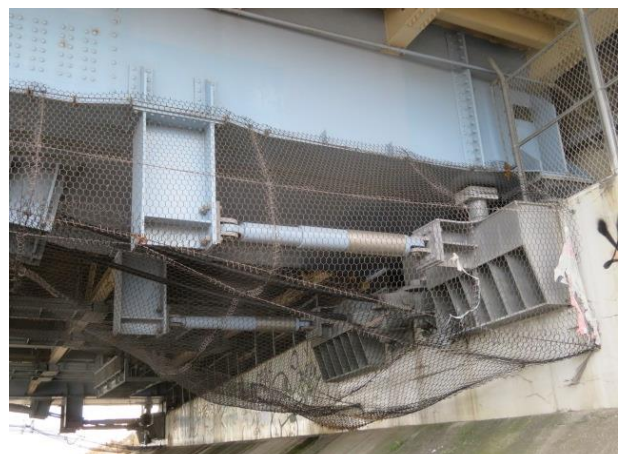
写真7 端支点拡大
