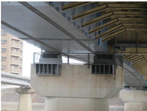
写真6 中間支点拡大
