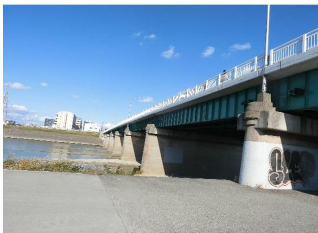
写真3 鋼製鉄桁
