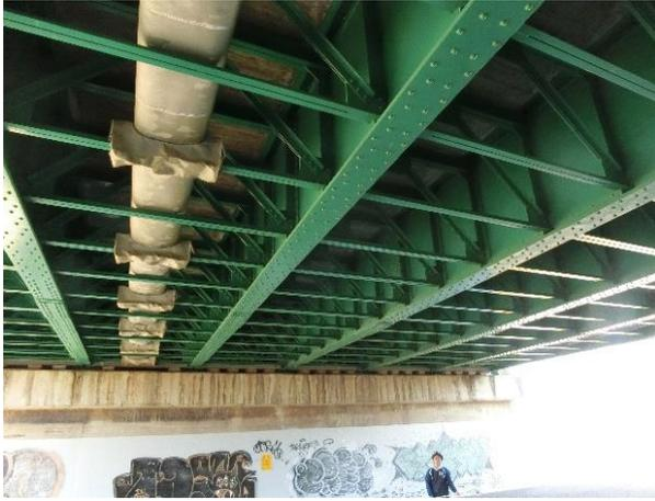
写真 5 桁裏格子構造(左:水道管 )
