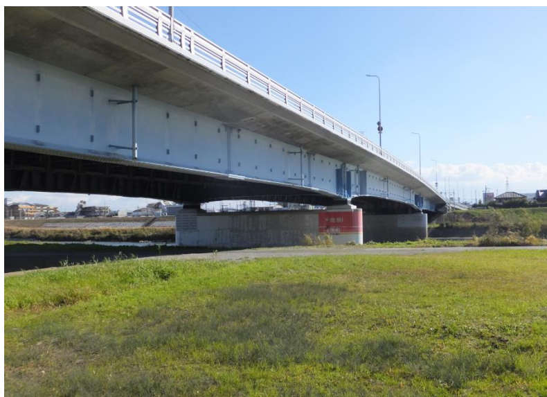
写真 1 吾彦大橋（右岸下流側より）
