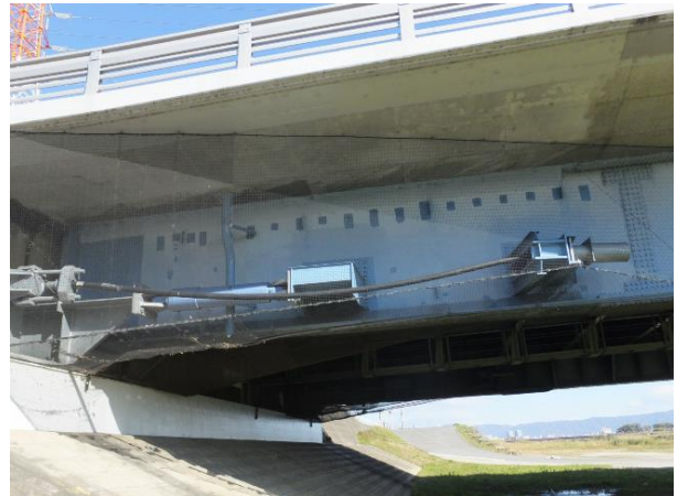
写真3 桁端の落橋防止装置
