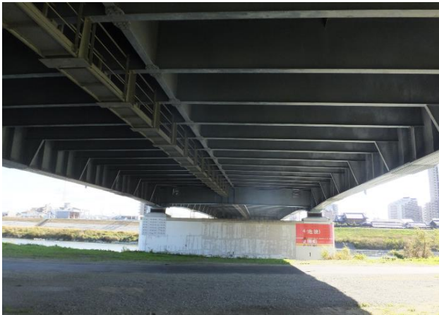
写真2 下面から見た橋
