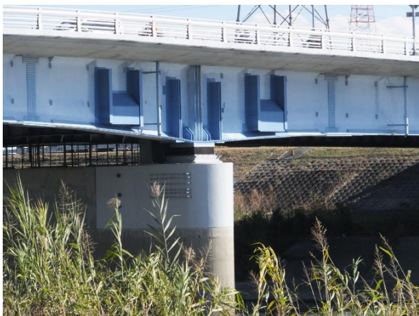
写真4 中間支点の桁外面
