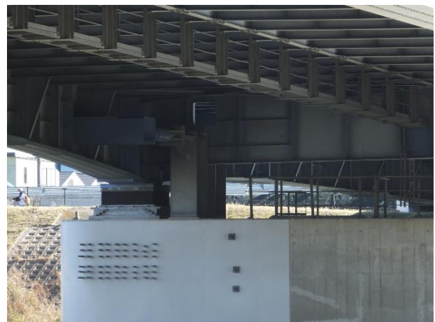
写真5 中間支点付近の桁内面の構造物
