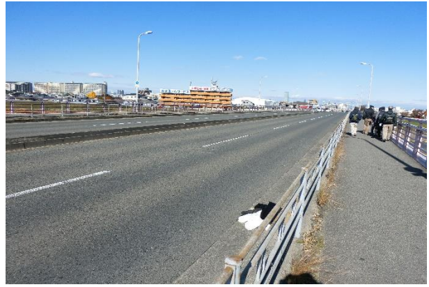
写真5 橋面（上流側歩道から）
