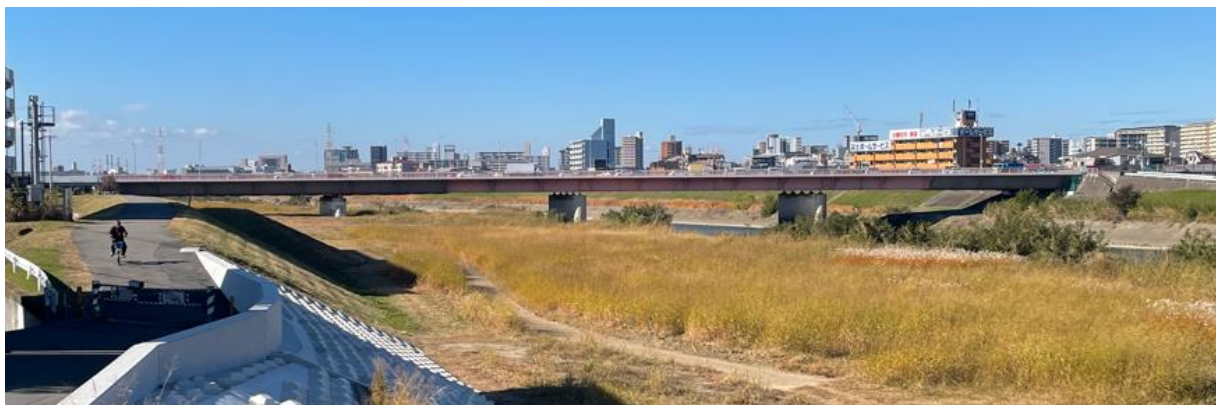
写真1 行基大橋（全景 上流左岸から）
