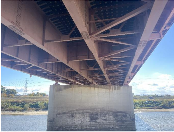
写真2 下面から見た橋
