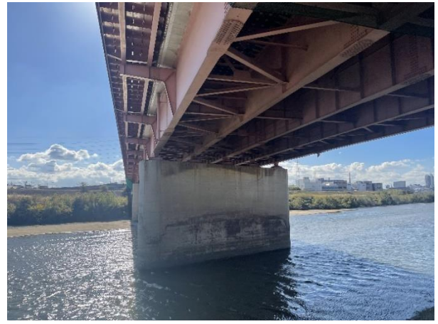
写真3 斜め下から見た橋
