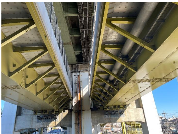
写真4 桁下の状況（右岸側より橋端部方向）
