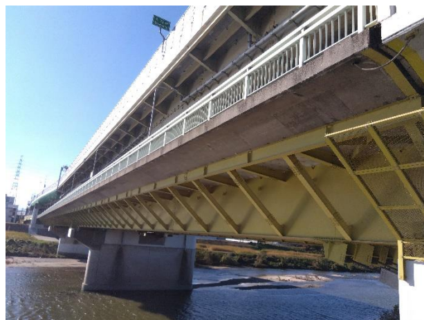
写真3 桁下の状況（右岸・上流側より）
