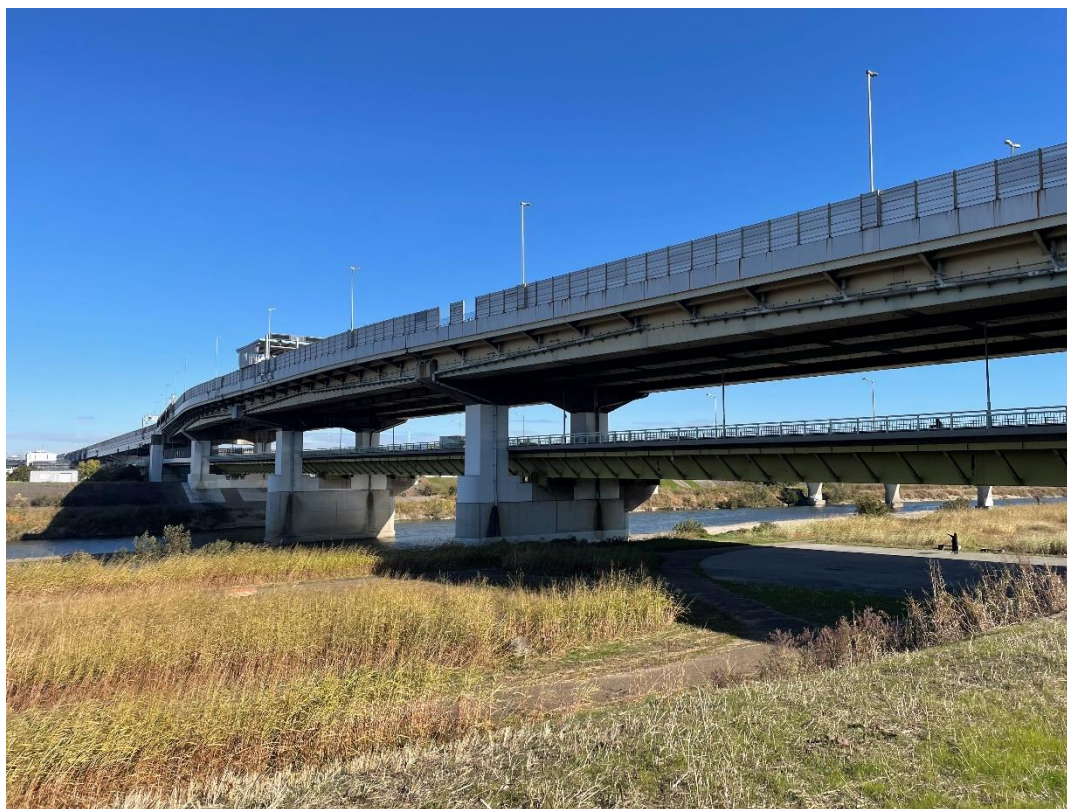
写真1 橋梁の全景（左岸・下流側より）
