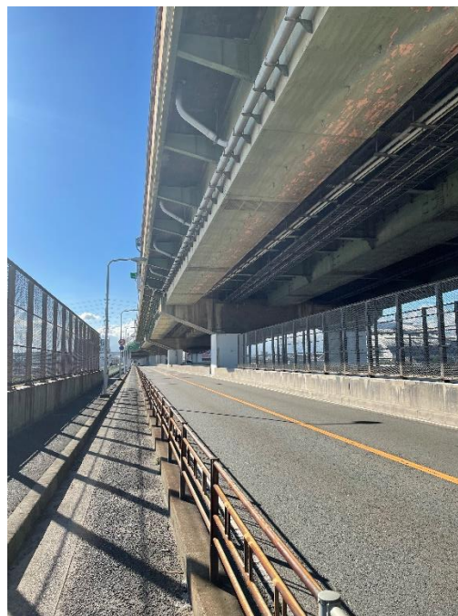
写真5 橋面の状況（右岸側より橋梁中央方向）
