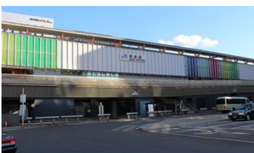
写真-1-4 奈良駅西口 高架駅
