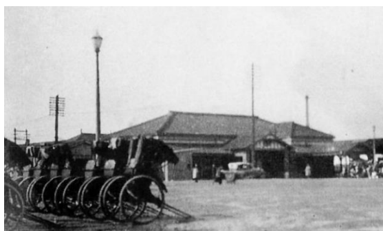
写真-1-1 初代奈良駅舎(昭和はじめ) 3)
