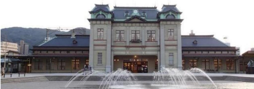
写真一六 門司港駅舎 11)
