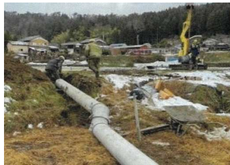
写真-3 仮復旧のための配水管（珠洲市）
