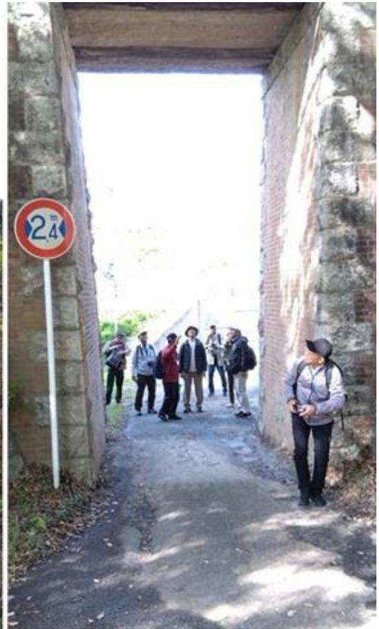
写真-8 赤橋：橋台が花崗岩と煉瓦で造られている
