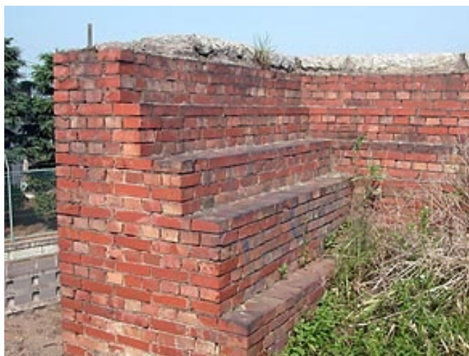
図-5 煉瓦式橋台の内部構造
