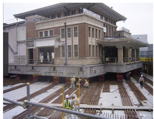
間瀬建設(株)施工事例写真より 6)
