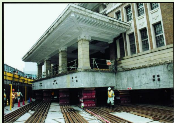
曳家工事の状況(出典:奈良市)
