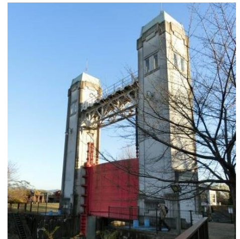
写真-2 三栖閘門
