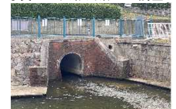
写真-2 築留二番樋
