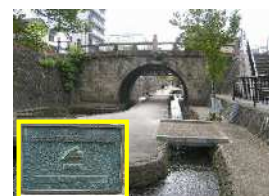
写真-4 堀川第一橋
