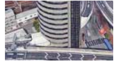
写真-4 TKPゲートタワー立体道路橋
