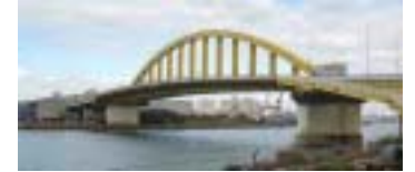
写真-5 泉大津大橋
