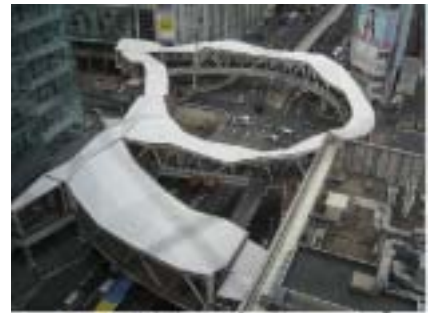
写真-4 阿倍野歩道橋
