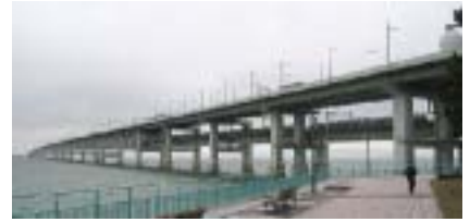
写真-3 関西国際空港連絡橋
