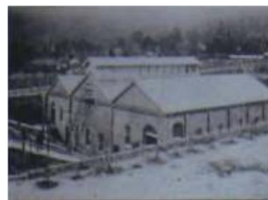
第一期蹴上発電所
