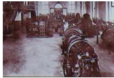
第二期蹴上発電所の内部
