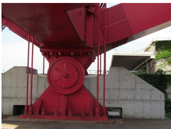
写真5 沓の耐震補強（港大橋） 3)
