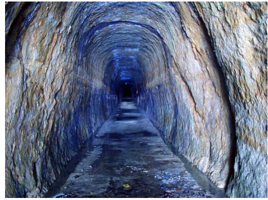
手掘り隧道 1 km
