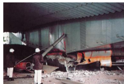
写真-6 鋼製橋脚の圧壊損傷
