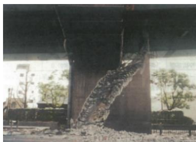
写真-5 RC橋脚のせん断損傷
