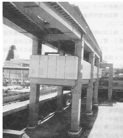
図1 被災したポートターミナル駅
