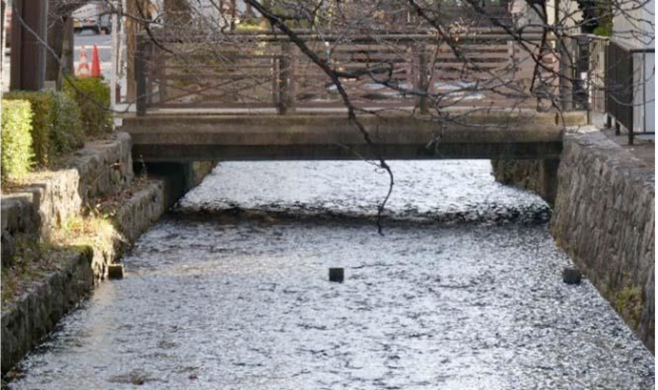
高瀬川の水位を調節する堰止め石
