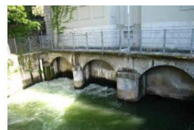
第三期蹴上発電所(放水口)
