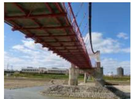
大大阪時代に当たる昭和初期の建設であるためか、遊園地へのゲートとして相応しいデザインと遊び心が施された吊橋である。構造的にも5径間連続は日本最多の径間数を誇り、ほぼ1世紀に渡り供用に耐えていることから、当時の技術力の高さが窺える。
