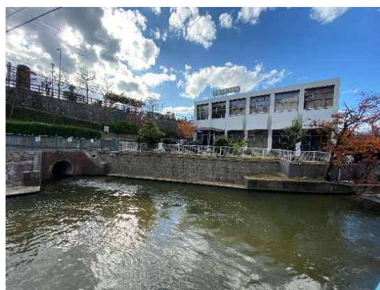
写真－ 1 築留二番樋と 築留土地改良区事務所
