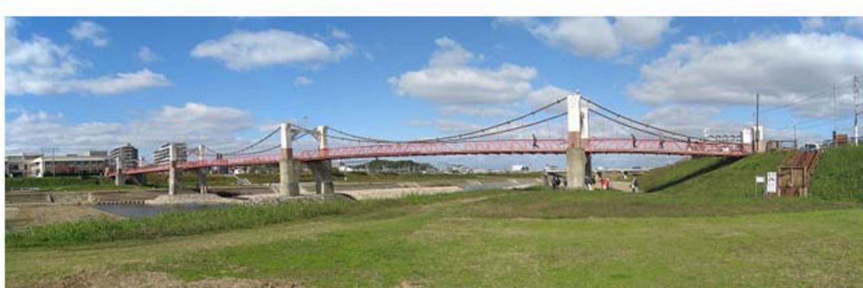
全景 (石川右岸上流側より)
