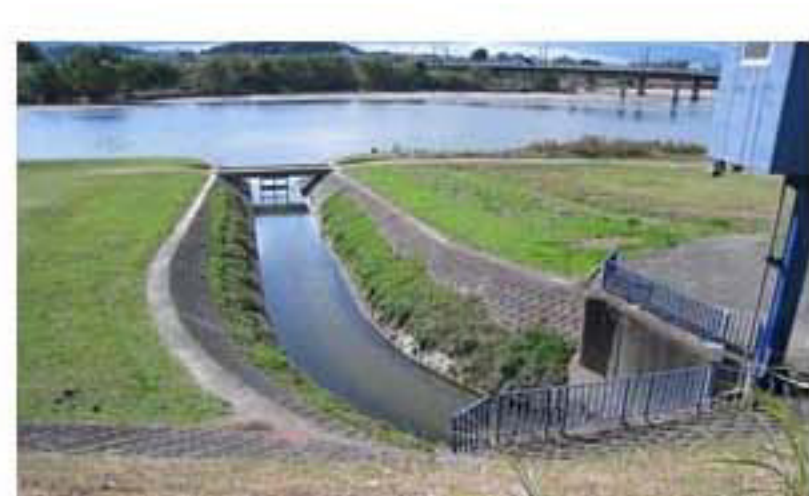
大和川からの取水路
