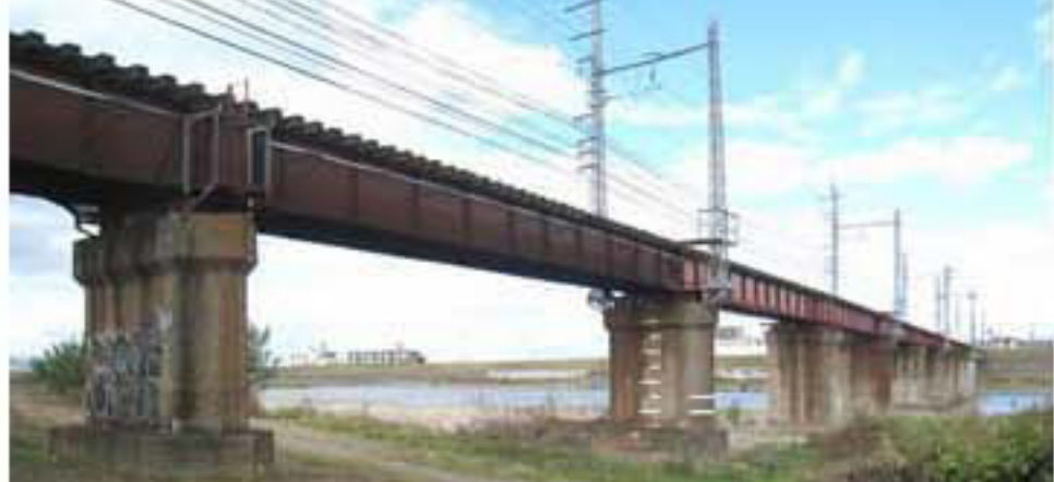
左岸上流側から
