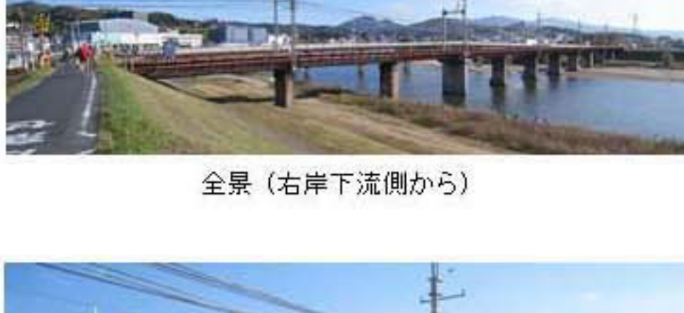
全景(右岸下流側から)
