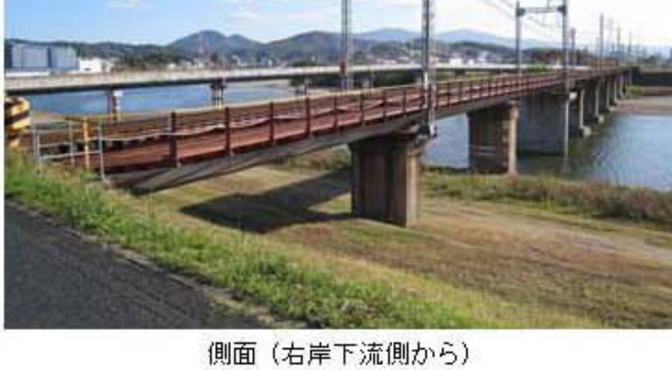
側面(右岸下流側から)
