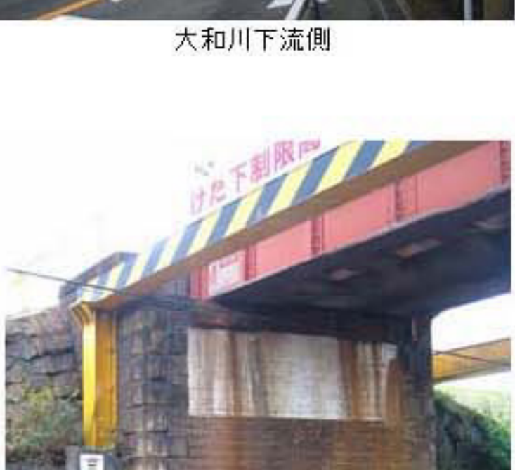
道明寺方橋台
