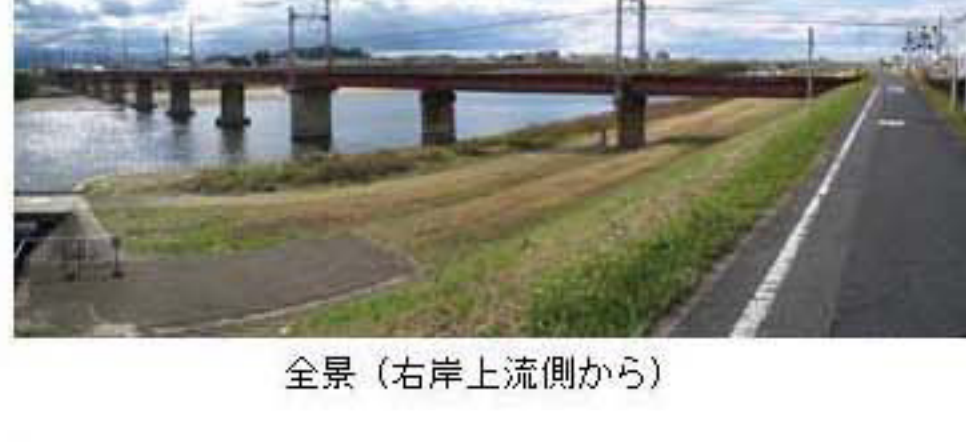
全景(右岸上流側から)
