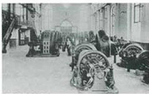
第2期 蹴上発電所内部
