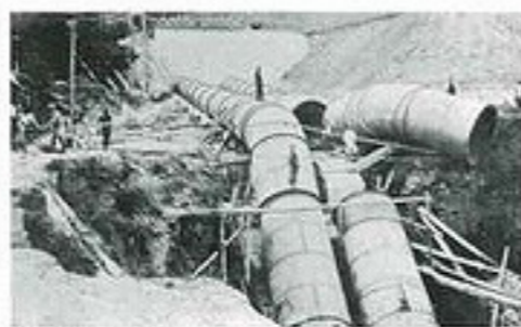
水送機製作工事(第2期工事)
