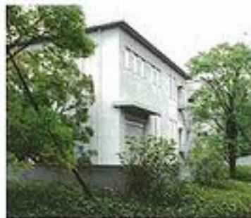
第3期 (旧) 蹴上発電所
