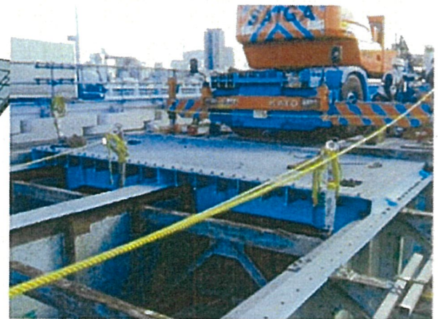
⑤鋼床版架設
