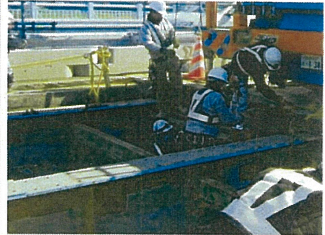
③高さ調整フィラー設置
