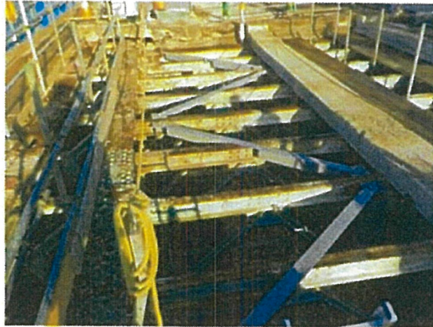
①仮設 上横構設置
