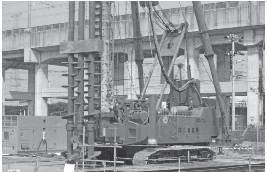
写真3 ECW-II型 大口径3軸装置
