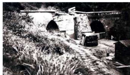
旧国鉄・関西本線トンネルの圧壊
