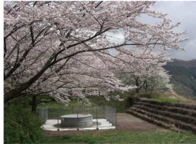
植樹された桜と集水井
