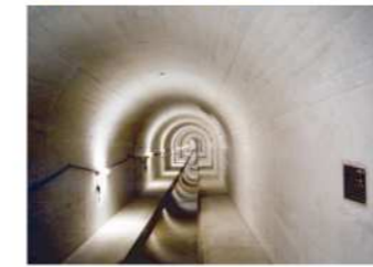
排水トンネル内部
