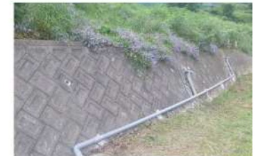
横ボーリング
