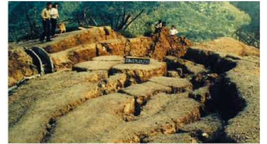
畑地の亀裂・陥没
