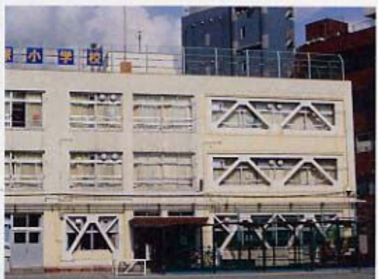
小学校の耐震補強
