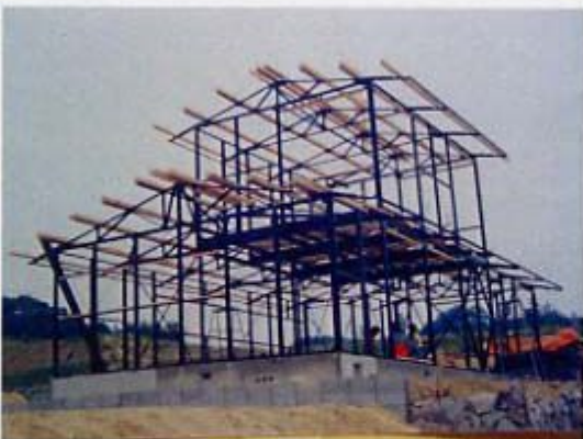
家の屋根組み
