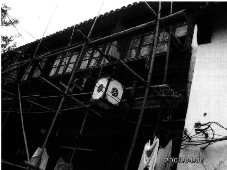
写真6 中国蘇州で建設中の住宅の足場として使われている竹(撮影: 村上悠紀子)
