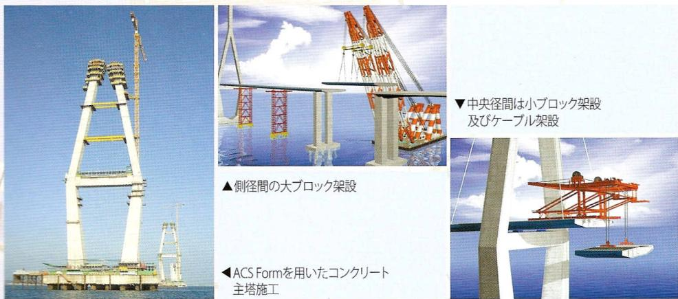
主塔はACS Formを適用して施工し、約1,600トンの主塔の横梁は製作場で一括製作して設置する。
