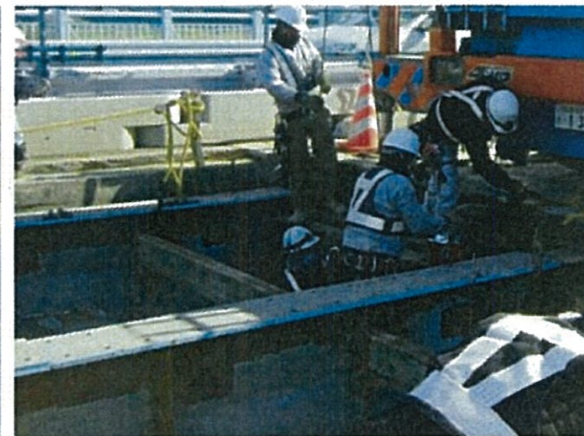
③高さ調整フィラー設置
