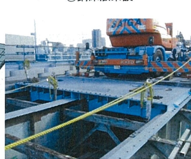
⑤鋼床版架設
