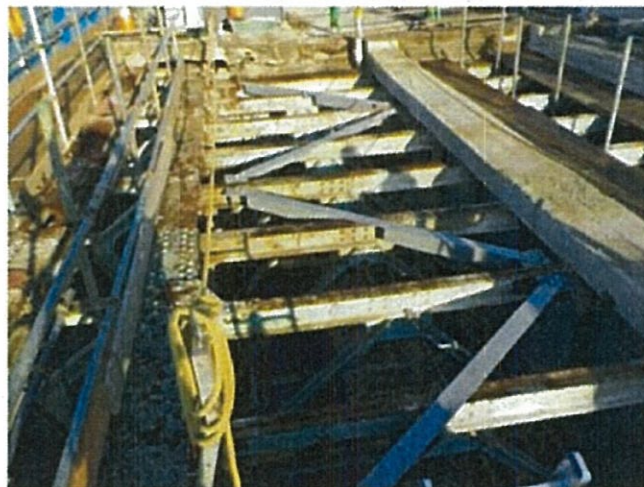
①仮設 上横構設置
